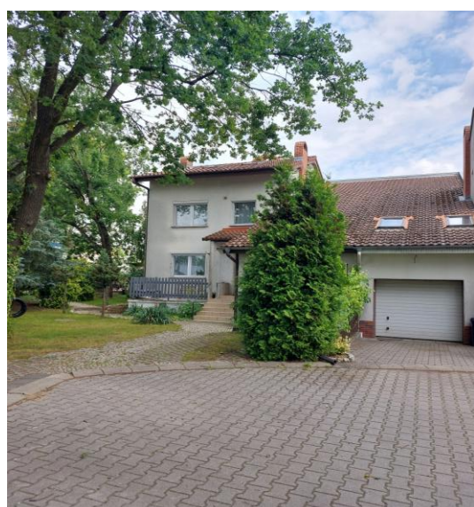
Budynek – widok ogólny
