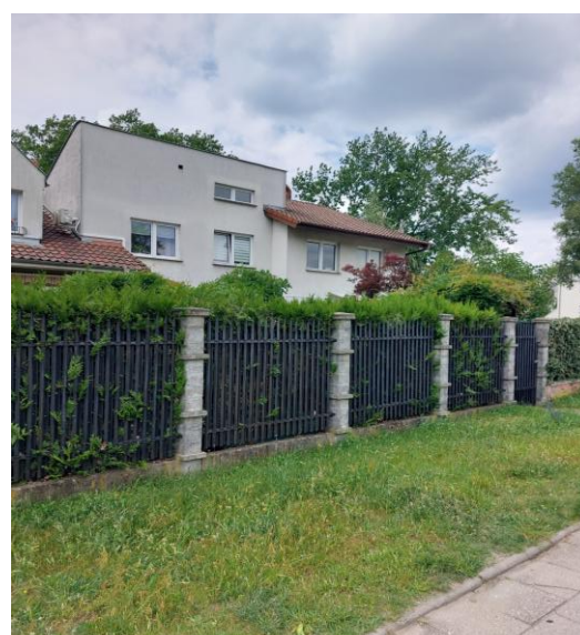
Budynek – widok ogólny
